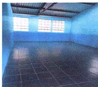
REGLÓN 4. COLOCACIÓN DE PISO CERÁMICO
