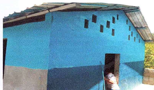
REGLÓN 2. REPARACIÓN DE LA COCINA DE LA ESCUELA.
