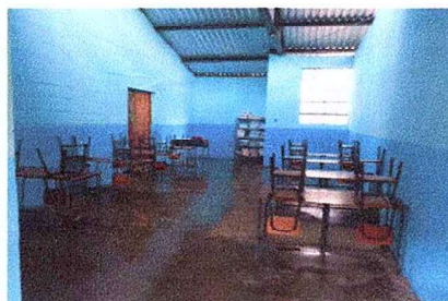
REGLÓN 4. REPELLO DE LA DIVISIÓN DEL AULA 1, 2 Y LA COCINA.
