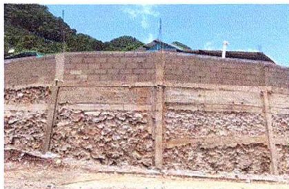
REGLÓN. 1 REPARACIÓN DE MURO DE CONTENCIÓN.
