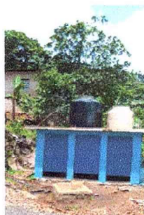
REGLÓN 3. SUSTITUCIÓN DE SERVICIO SANITARIO.
